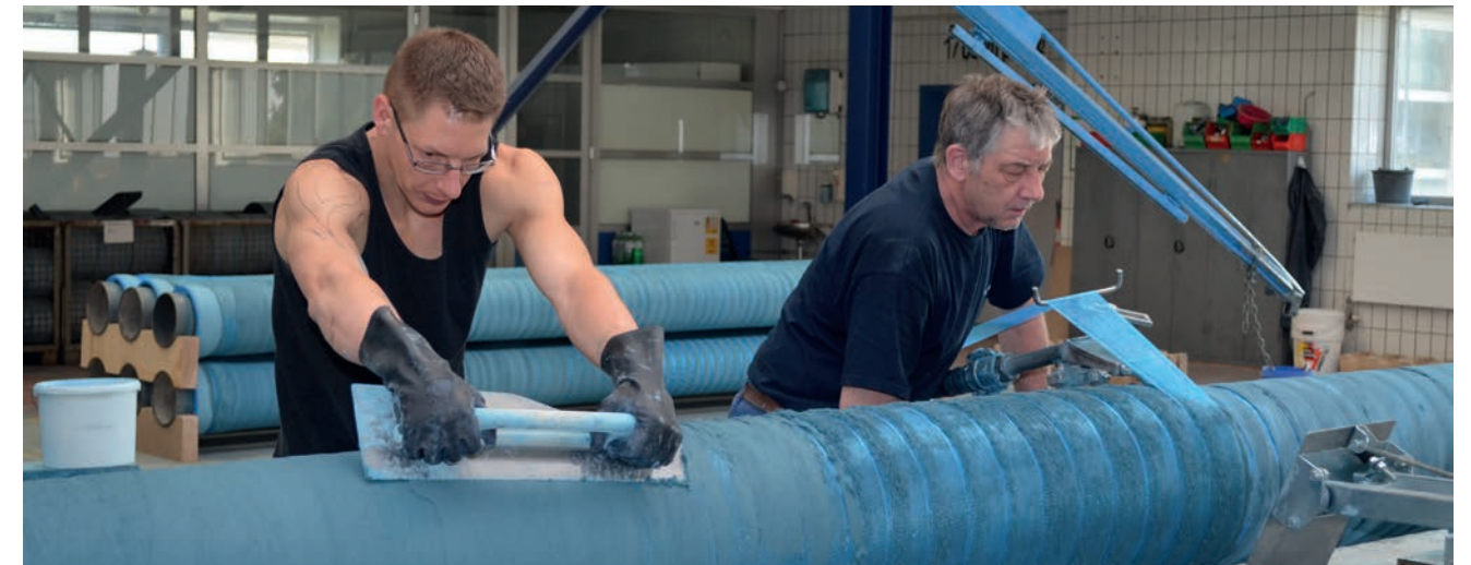
Wie man unschwer erkennen kann, ist beim Aufbringen des Faserzementmörtels (FZM) viel Fingerspitzengefühl gefragt. Man beachte auch die Bandage, die den Zementmörtel stabilisiert und beim Ablängen der Rohre dessen Ablösung auf Muffeneinstecktiefe erleichtert.
