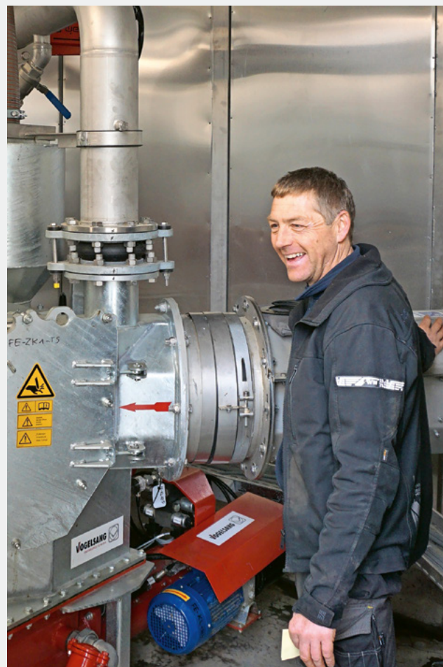
Fig. 5 Der Pionier und seine Anlage: Jean-Luc Bonjour erklärt, wie die Gülle gefiltert wird, bevor sie in den Fermenter gelangt.
