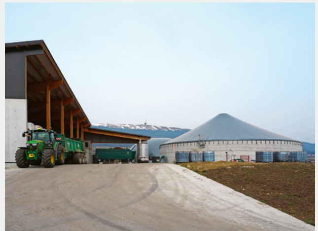
Fig. 1 Blick auf das Biogaskraftwerk von TeamEnergie SA in Lignières mit dem Chasseral im Hintergrund. (Fotos: © R. Bürgi)
