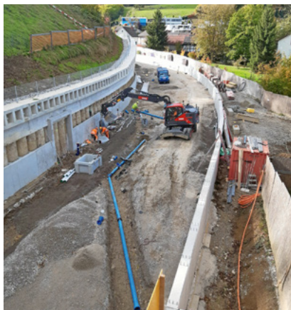
Leitungsverlauf in der Umfahrungsstrasse.
