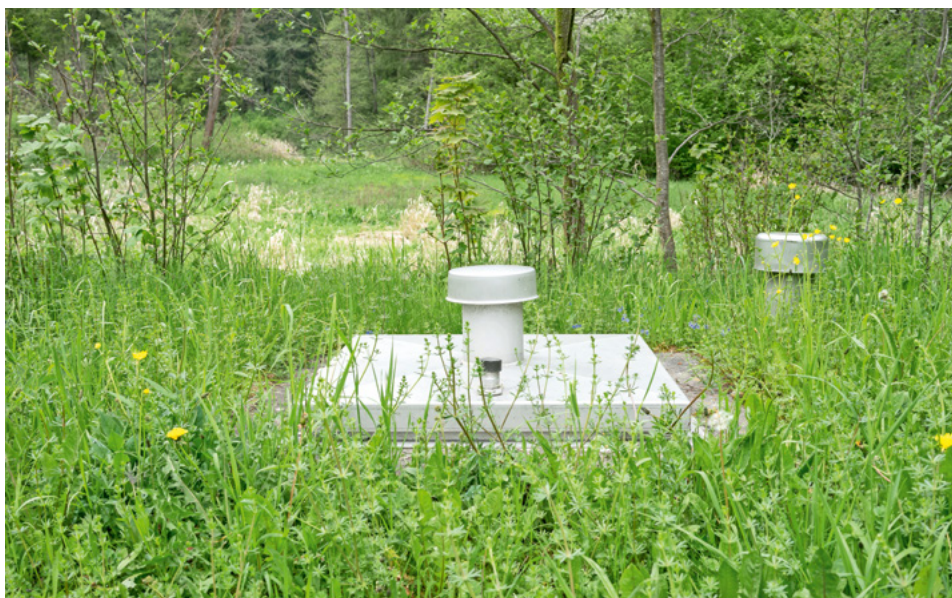
Der öffentlichen Trinkwasserversorgung muss gegenüber konkurrierenden Nutzungsansprüchen wie von Landwirtschaft oder Industrie stets Vorrang eingeräumt werden. (©TomBal/Adobe Stock)
